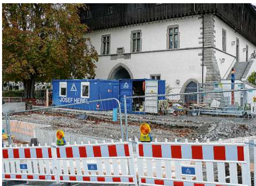
Die Marktstättenunterführung ist hier abgesperrt und der Durchgang dadurch schmaler, hinter dem Bauzaun wird am Konzil eine Treppenanlage erstellt. BILD: CLAUDIA WAGNER
